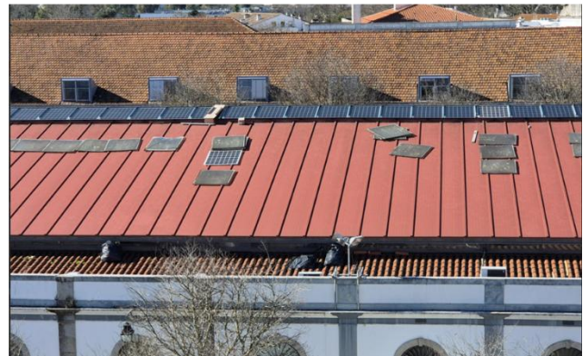
Figura 22: Implementación de Vidrio Solar en edificios en Évora y ejemplos de muestras (esquina superior derecha).
