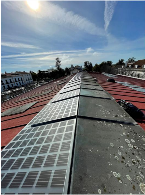
Figura 22: Implementación de Vidrio Solar en edificios en Évora y ejemplos de muestras (esquina superior derecha).
