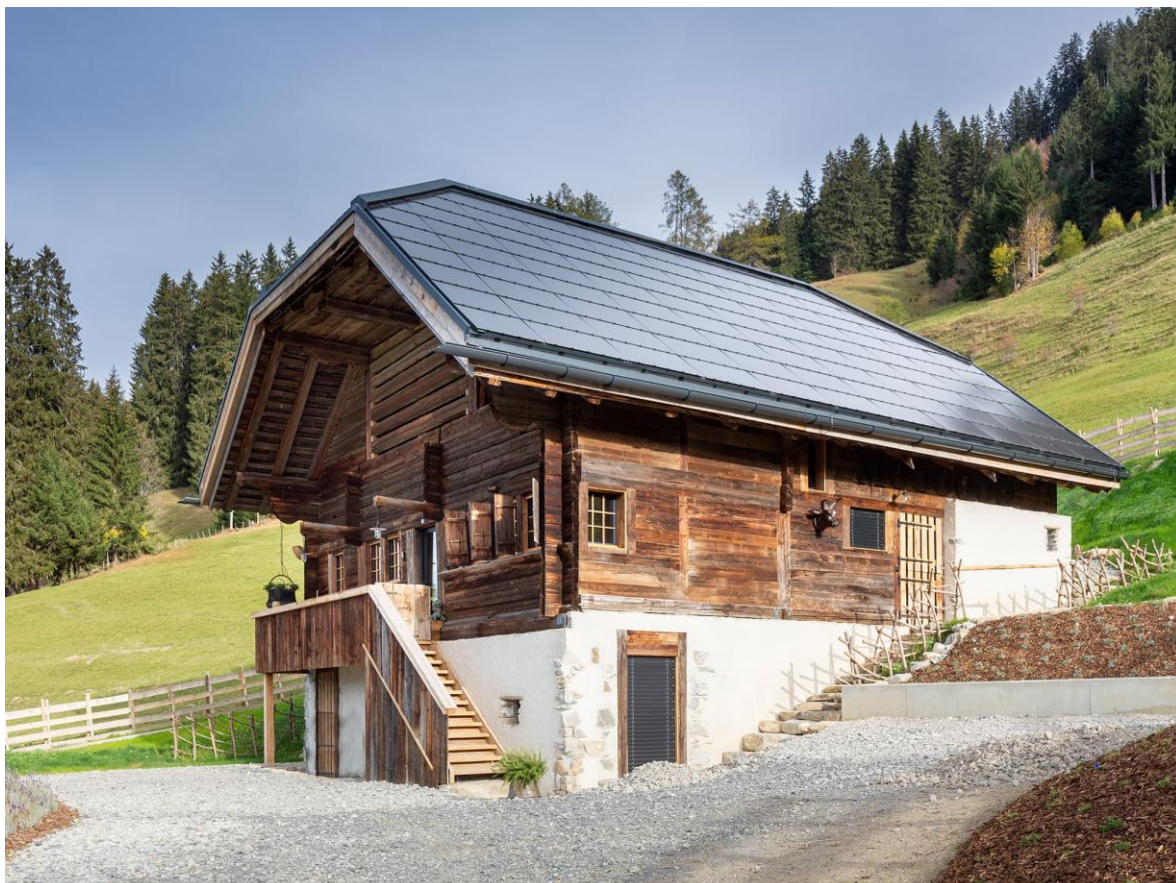
Figura 3: Tejado solar, fuente: 3S Swiss Solar Solutions
