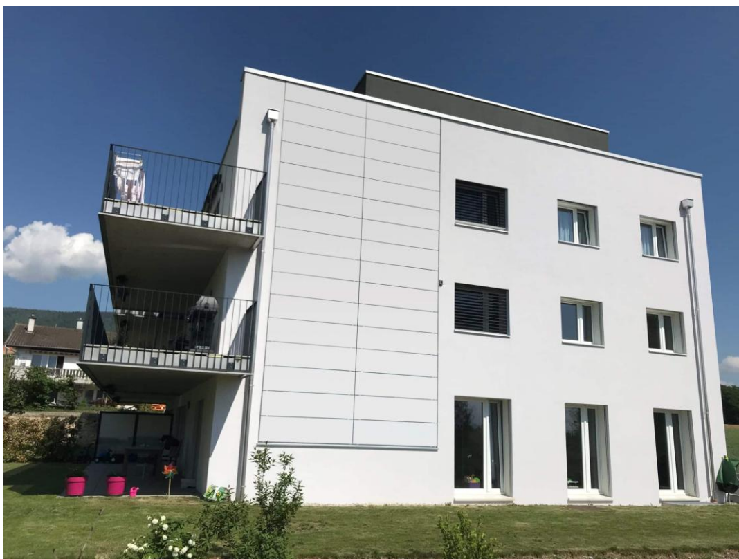
Figura 8: Fachada de módulos fotovoltaicos blancos, fuente: Solaxess
