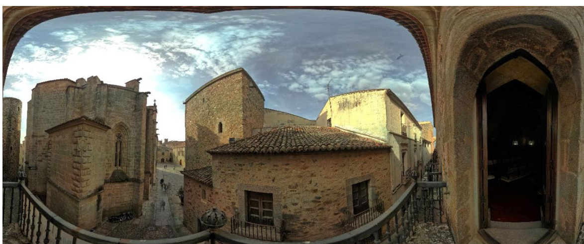
Figura 4. panorámica de muestra en zona exterior del edificio de arquitectura tradicional Palacio Carvajal ubicado en Cáceres. Fuente: Anexo 1 levantamiento aplicando láser escáner 3d para generación de nube de puntos y modelado BIM
